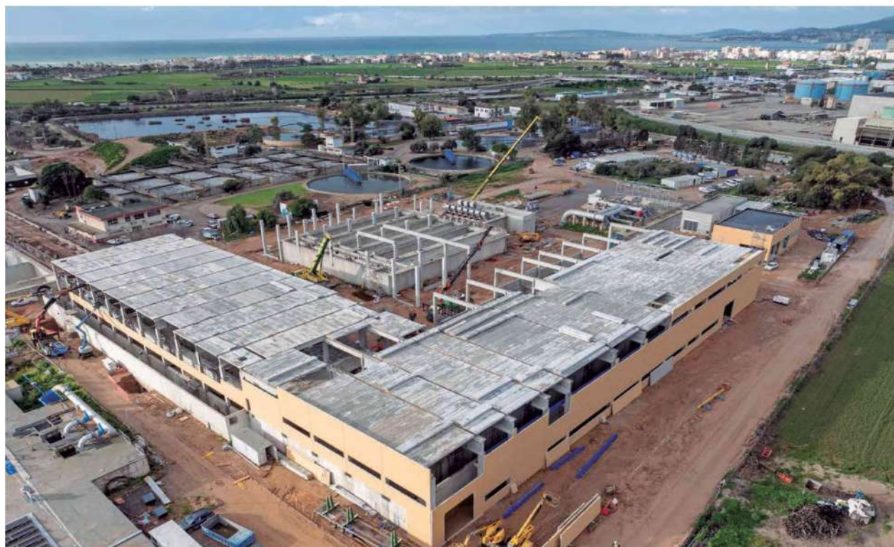
Ampliación y remodelación EDAR Palma II
